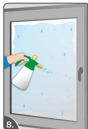
8. Nochmals die Folie mit Montagewasser besprühen. Danach die Folie wieder mit Druck von der Mitte nach außen rakeln - Solange, bis das Wasser maximal herausgerakelt wurde.
